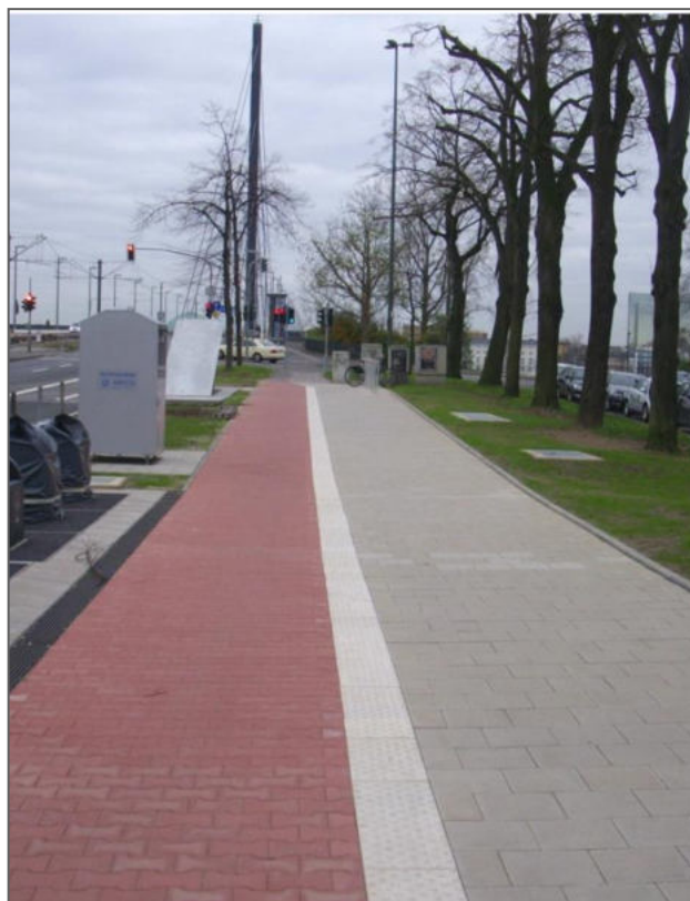
Bild 5-5: Getrennter Fuß- und Radweg
