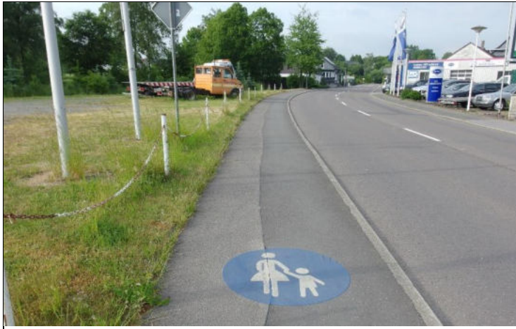
Bild 5-14: L 284 südlich Dreiner Weg
